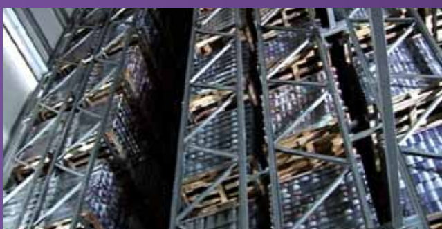
Автоматический накопитель банок (7.000 поддонов)
