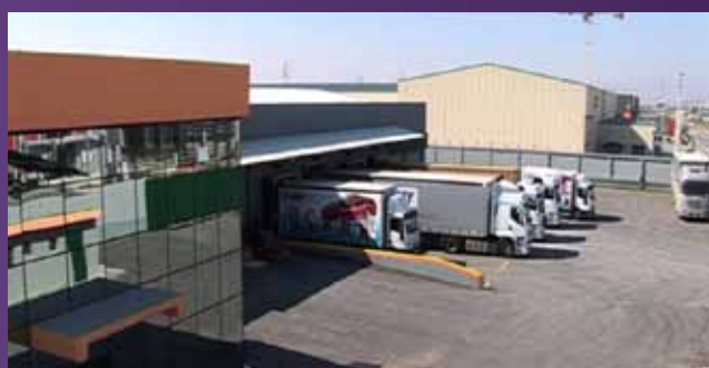
Складской центр площадью (11.000 m 2 )
